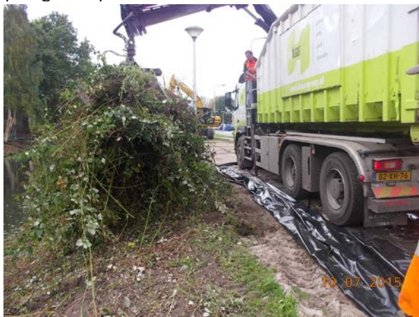
Figuur 1. Verwijderen maaisel met materieel op folie ter voorkoming van verspreiding.
