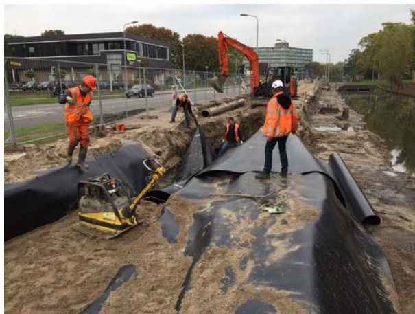
Figuur 2. Afdekken gasleiding met 2 mm HPDM folie.
