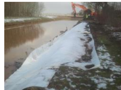
Afdekken met geotextiel Bron: Probos
